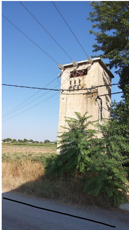
Ilustración 7: (3.5) Cable telefónico y zanja MT
