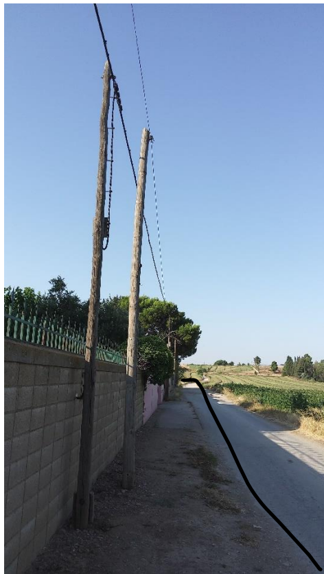
Ilustración 4: (2.2). Cable telefónico y zanja MT
