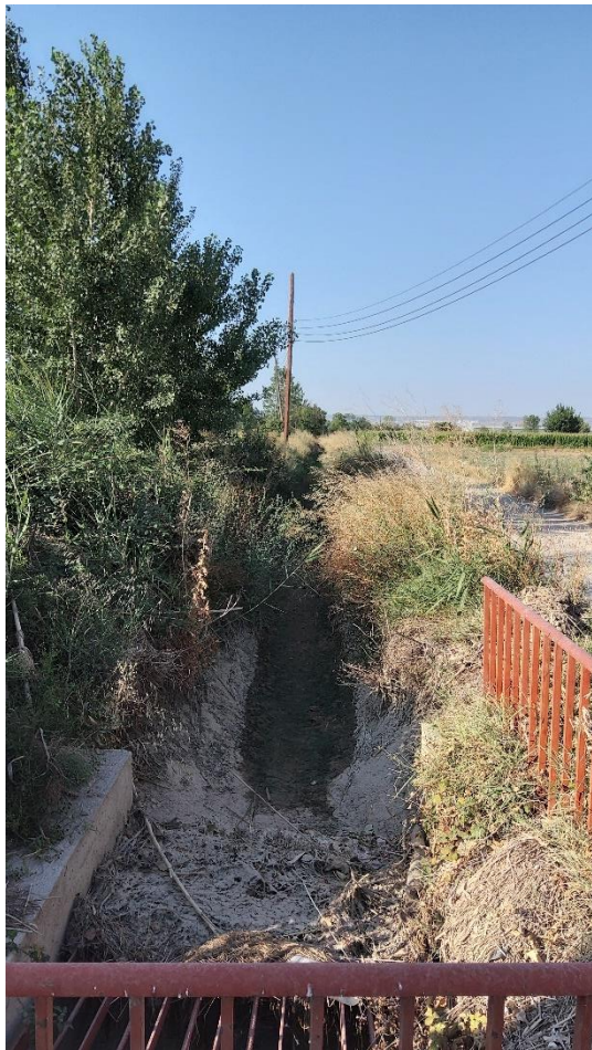
Ilustración 6: (3.4) Cable telefónico y zanja MT
